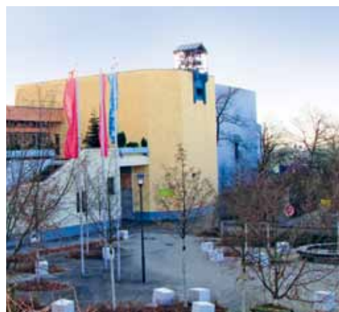
Im westlichen Teil des Gebäudes ist die Kapelle mit dem Glockenturm untergebracht.
