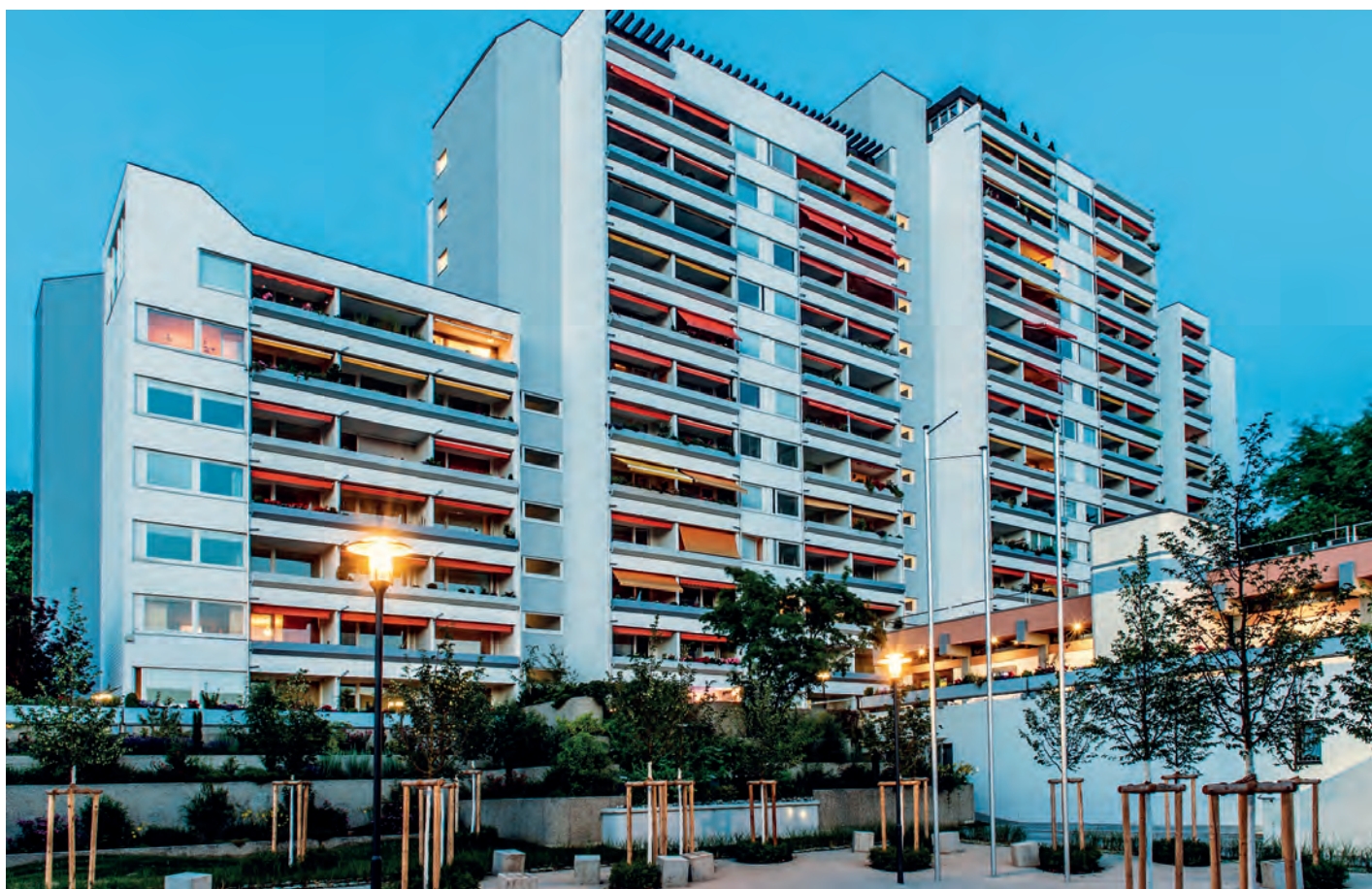
Das imposante Gebäude zwischen Wald und Reben mit herrlichem Blick ins Rheintal, hier bei hereinbrechender Dämmerung
