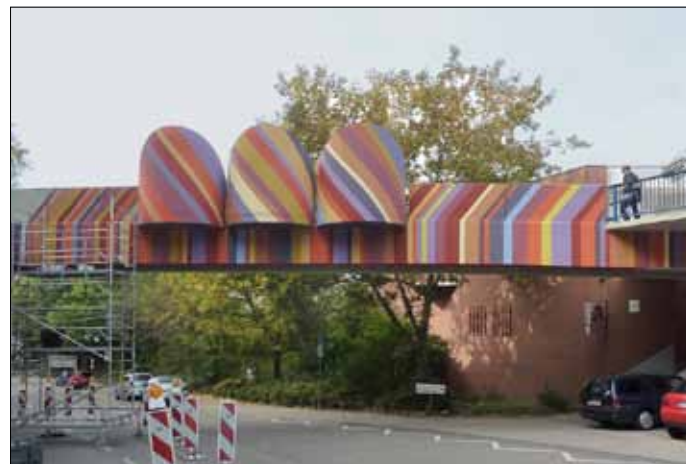
Kurz vor der Fertigstellung ist hier die künstlerische Gestaltung der zweiten Brücke, der Fußgängerbrücke am Forum.
