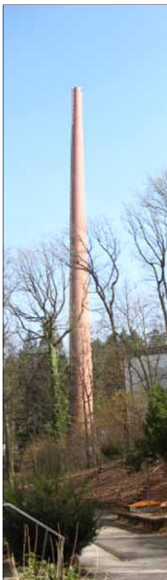
Schornstein des Heizkraftwerks im Boxberg Foto: Herth
