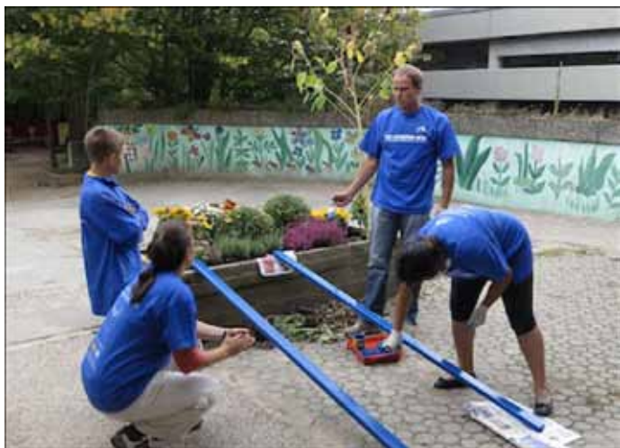
Kein geringerer als Oberbürgermeister Eckart Würzner (3.v.l.) legte bei den Renovierungsarbeiten Hand mit an. Foto: Björn Kindler
