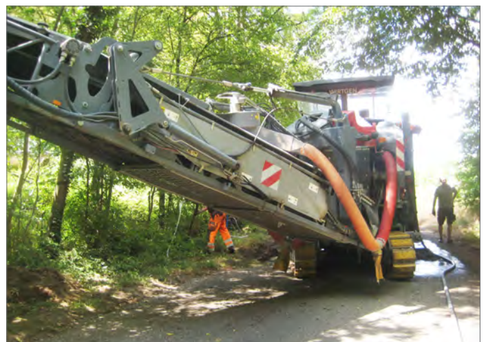
Mit 1500 Liter Diesel war das Kettenfahrzeug betankt, das den Asphalt fräste. Damit der Boden durch die Erhitzung nicht zu brennen anfängt, bekam das dahinter herfahrende Wassertankfahrzeug immer wieder laute Hupsignale, wann der Belag mit Wasser zu kühlen war. Foto: wa
