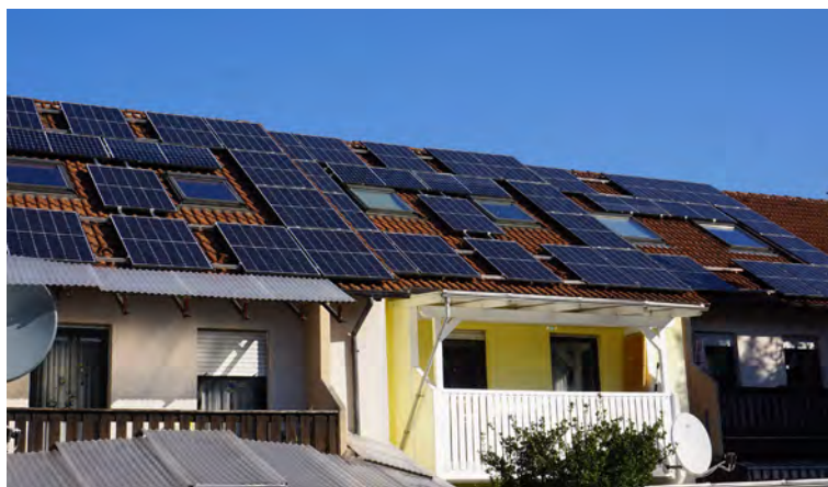
Die Solarpaneele auf den Dächern von Botheplatz 120, 122 und 124
